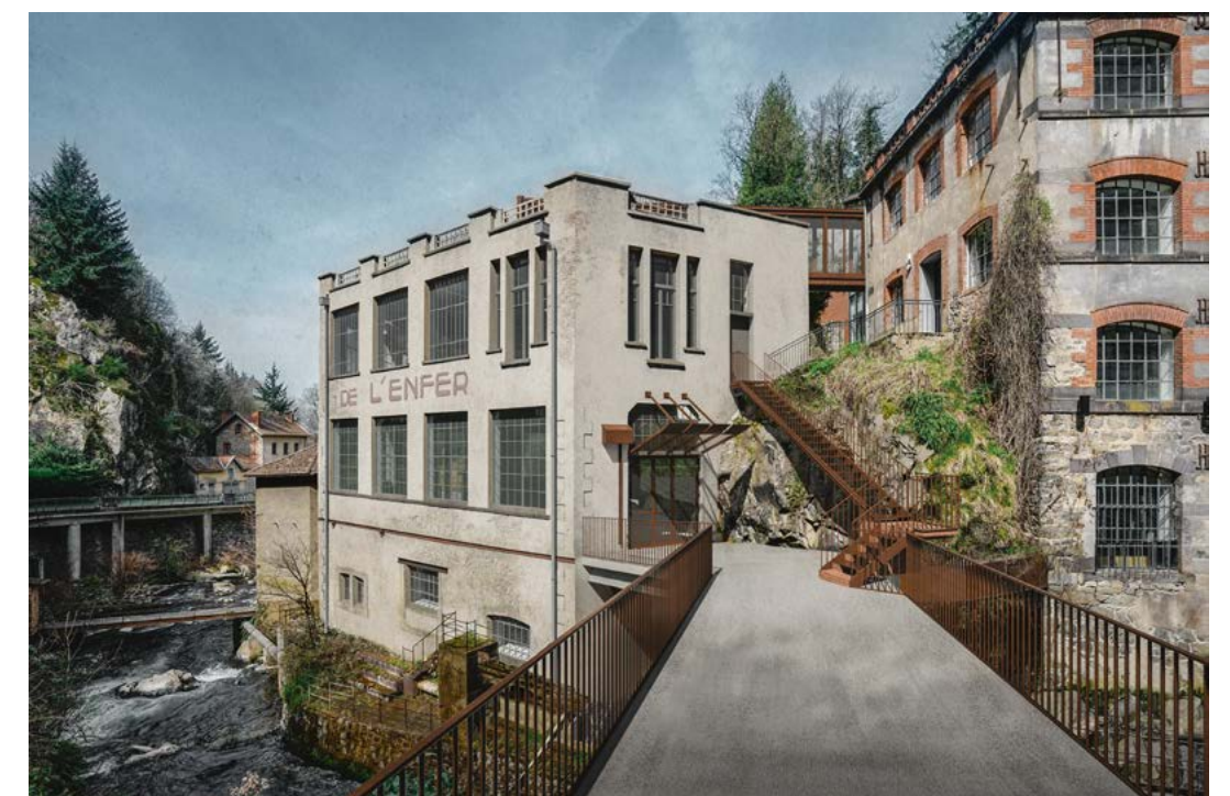
Les usines du Creux de l'Enfer (à gauche) et du May (à droite) après la restauration. © Fabre/Speller
