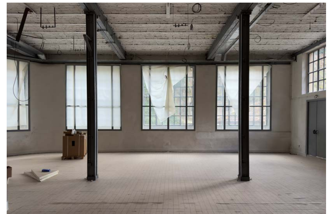
Chantier en cours au rez-de-chaussée de l'usine du Creux de l'Enfer, 2024. © Alexandre Bagros-Murat
