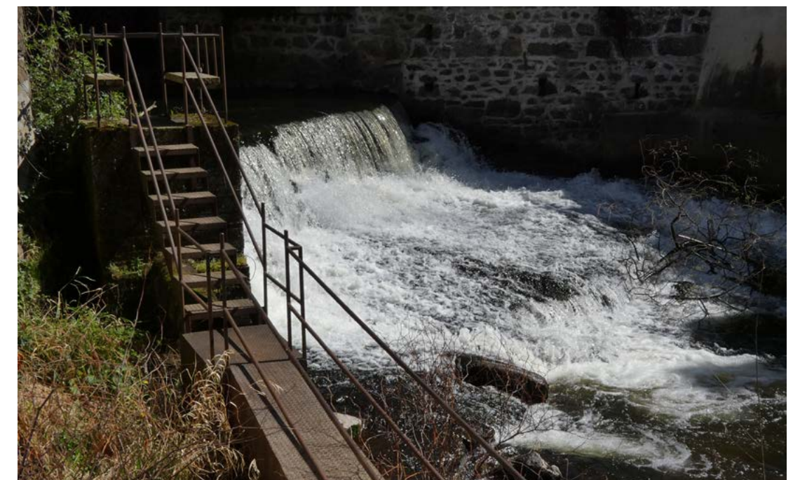
État d’une portion des passerelles (1985-2001) de George Trakas restaurées en 2025. © Le Creux de l’Enfer
