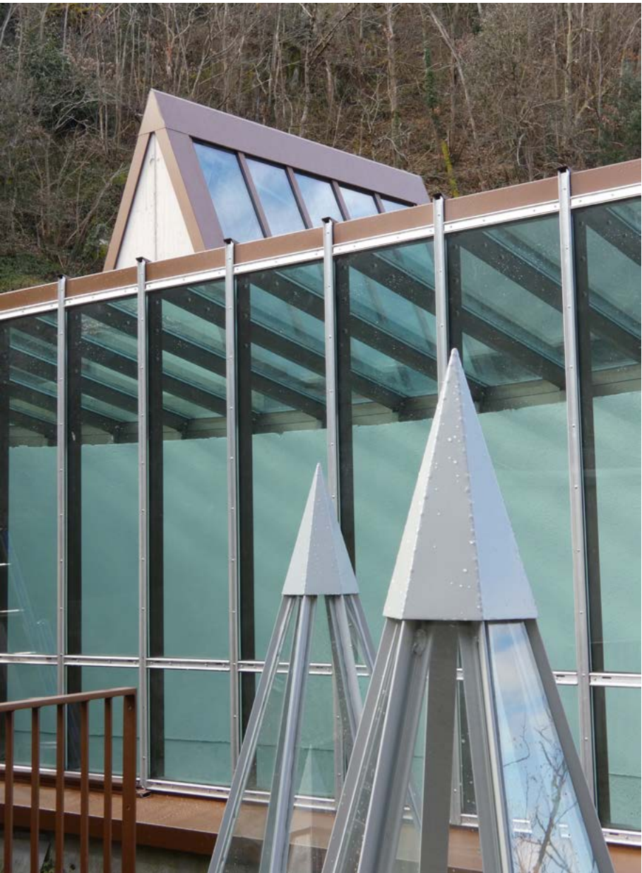
Détail de l’édicule menant au belvédère et à la passerelle, construit sur le toit-terrasse. © Maëlle Chambon
